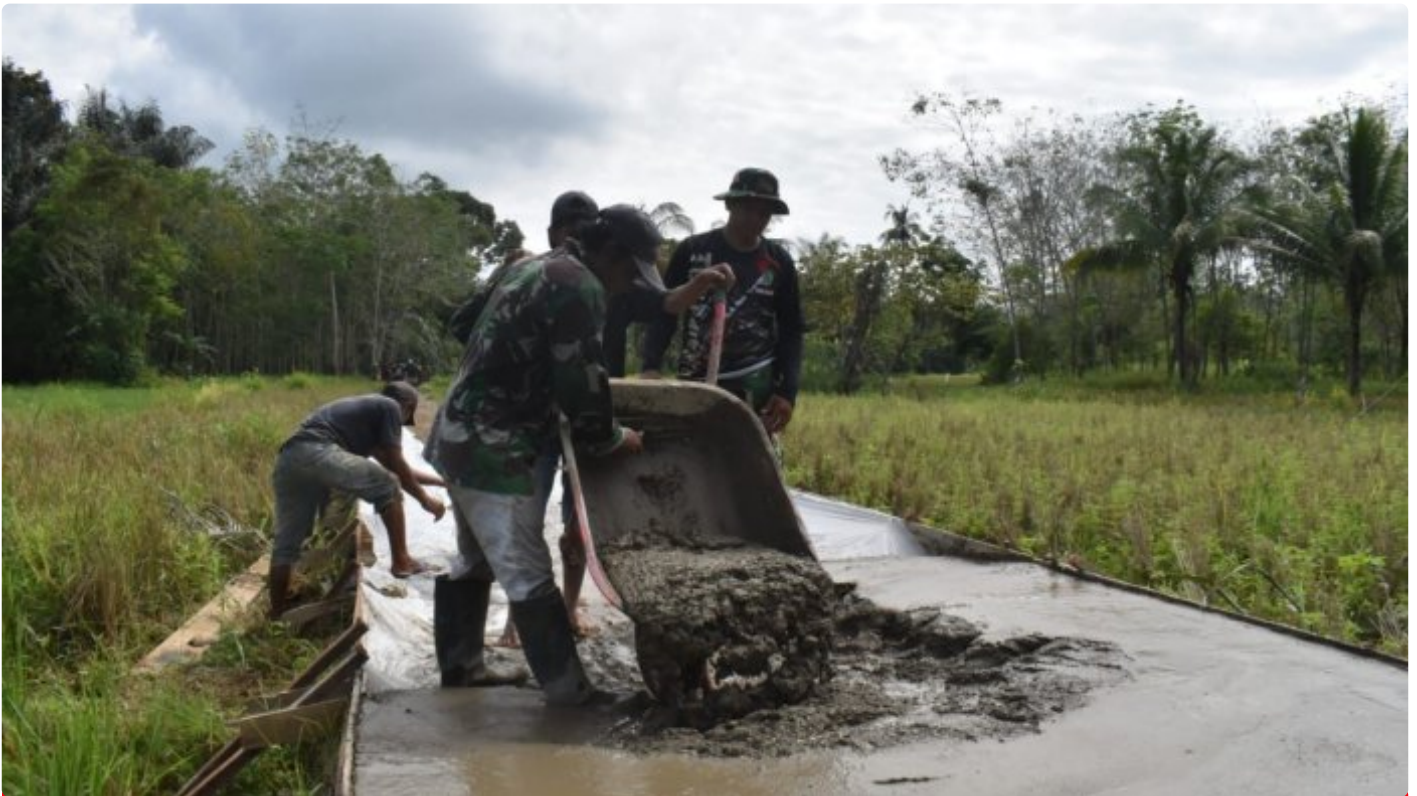
TMMMD ke-116 Kodim 1002/HST Terus Genjot Pengerjaan Jalan
